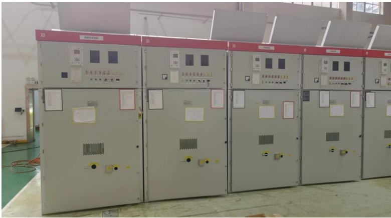
图 1.4 铠装移开式交流金属封闭开关柜
